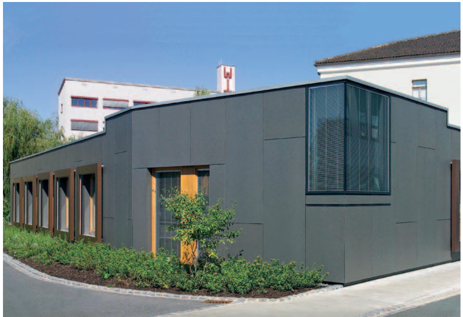
Mit Faserzement gebaut: Interessante Lösungen sind möglich ...
